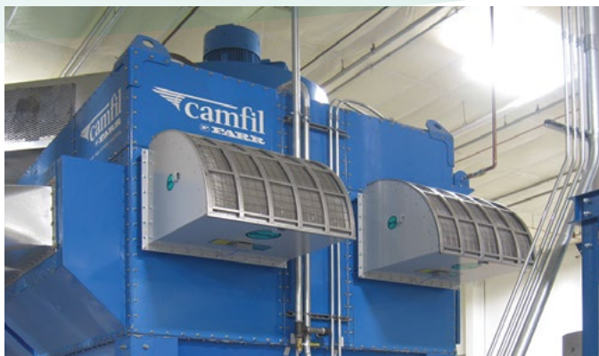
Indendørs flammefri eksplosionsafkastning
