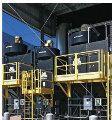
Ventilation af svejserøg
