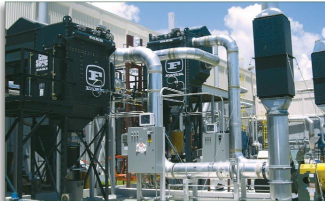
Staubabscheider mit Sicherheitsbehälter für gefährliche Stäube
