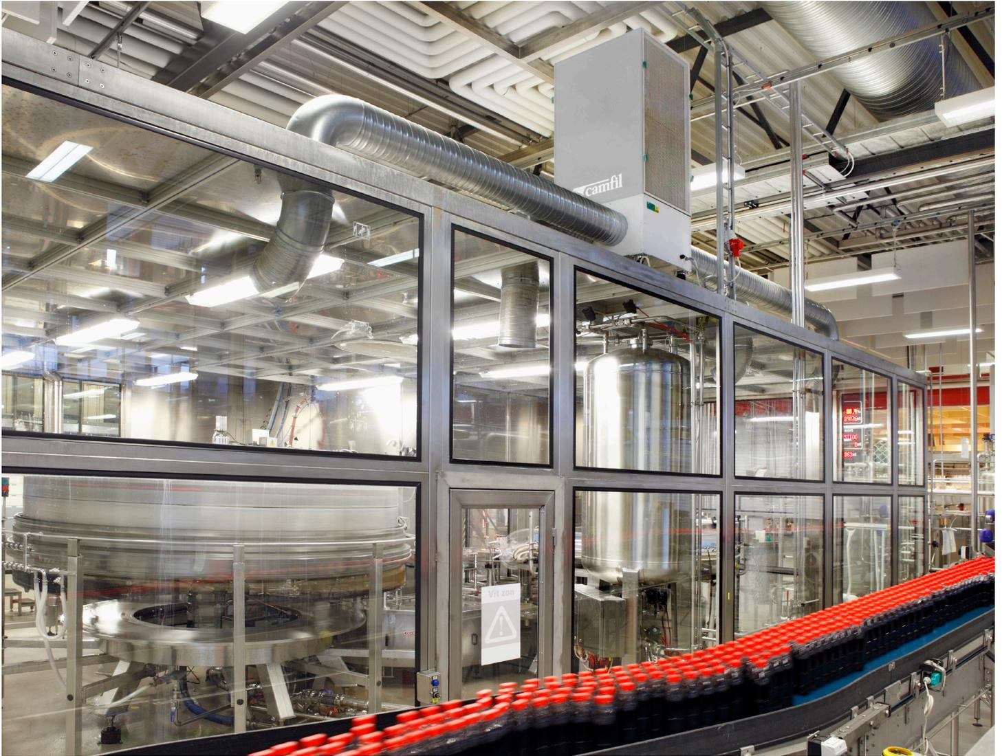
La imagen muestra una planta de embotellado que requiere una elevada cantidad de aire limpio detrás de las superficies acristaladas. El aire del exterior entra en el purificador y pasa a través del filtro HEPA de alta eficacia antes de ser dirigido a la planta de embotellado.
