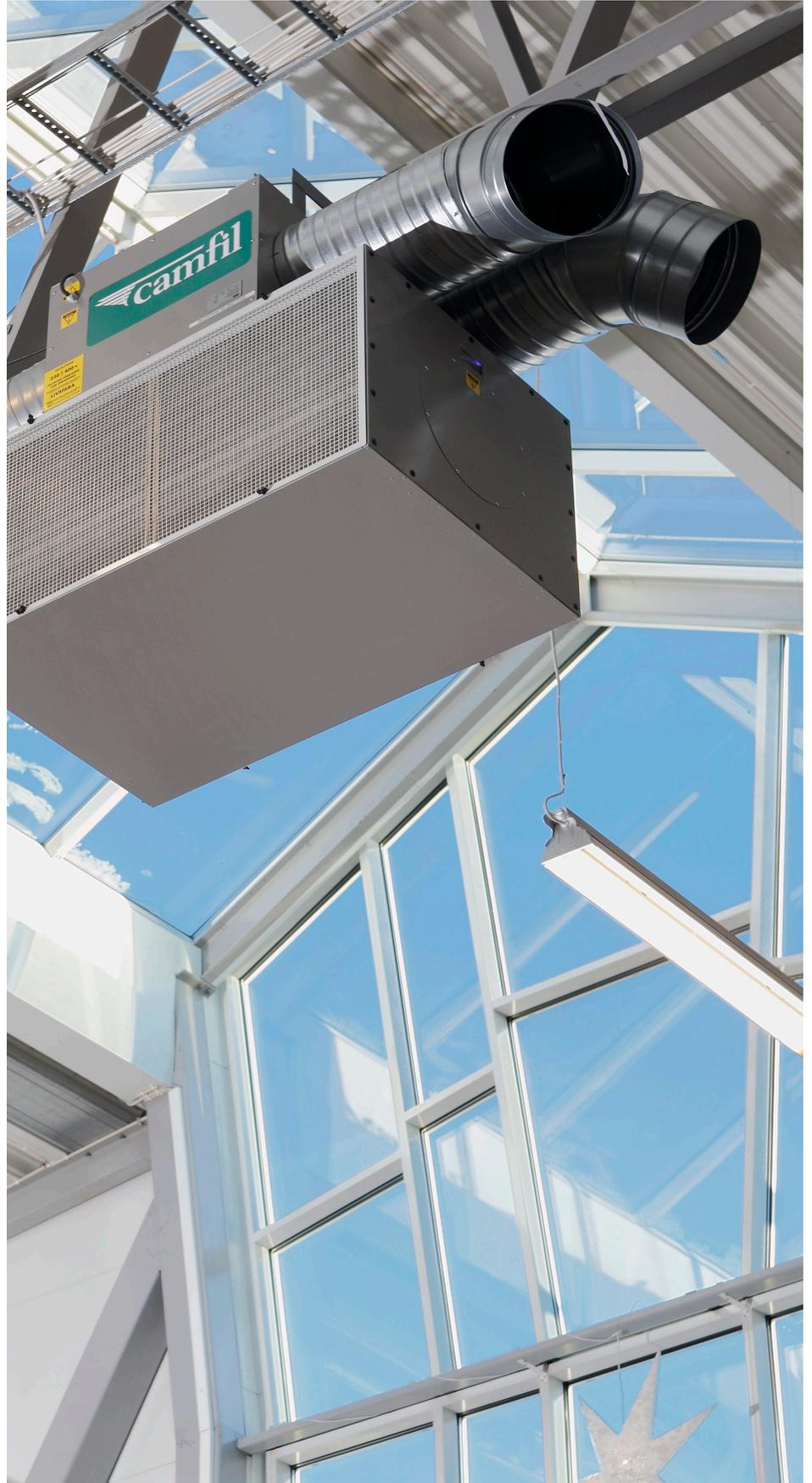
Un purificador de aire instalado en el techo purifica eficazmente el aire de nanopartículas, así como de grandes porciones visibles de polvo. Al mismo tiempo, el aire se mezcla nuevamente, lo que proporciona una temperatura media más alta a nivel del suelo.
