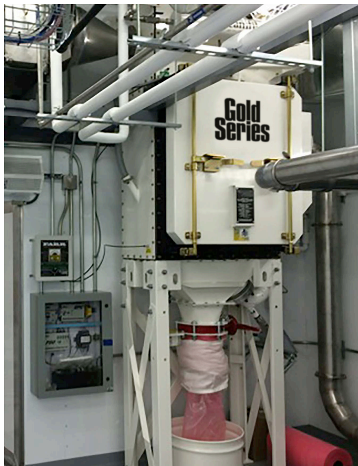
El captador de polvo Gold Series (GSC2) de Camfil se encuentra en una sección del POD, que está dividido en seis secciones.
