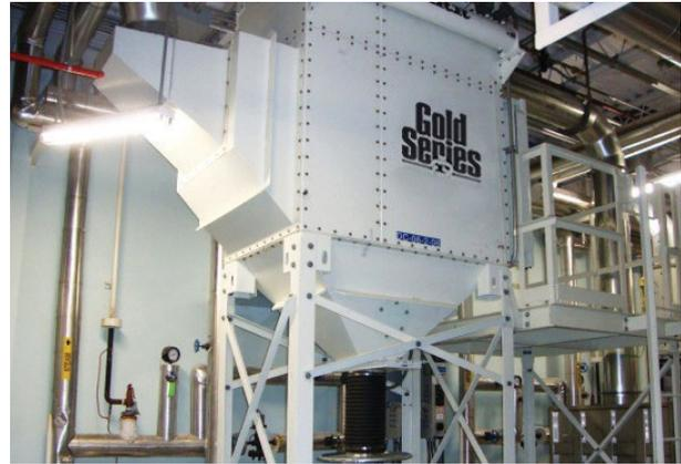
Ejemplo de instalación de un sistema típico de extracción de polvo.
