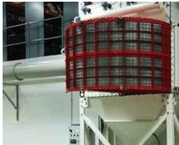
Diseñado para instalarse sobre un ventoe anti-explósión estándar, el ventoe anti-llama extingue el frente de llama que sale del área venteadada, impidiendo que salga del equipo. Esto permite que la ventilación convencional se realice en interiores donde, de otro modo, podría poner en peligro al personal. No pueden ventear hacia otra área clasificada (riesgo de ignición secundaria).
