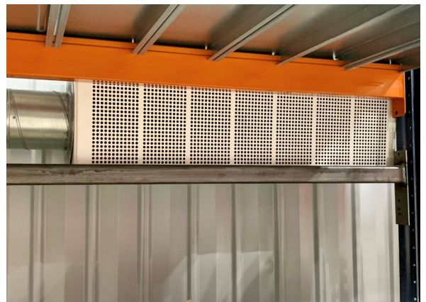
Puhallusventtiili asennettuna lavahyllyn alle lähelle lattianrajaa
