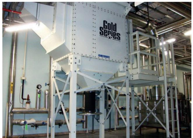
Beispiel für die Installation eines typischen Entstaubungssystems.
