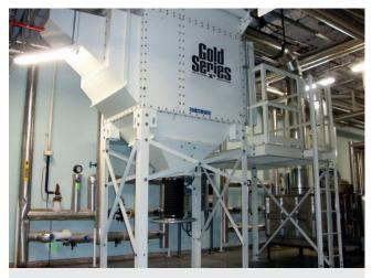
Beispiel für die Installation eines typischen Entstaubungssystem.
