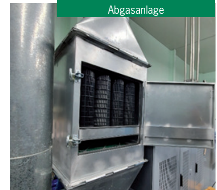
CamCarb CG 3500 in der Abgasanlage
