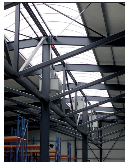
Fünf Luftreiniger CC 6000 direkt an den Deckenprofilen des neuen Distributionszentrums befestigt.
