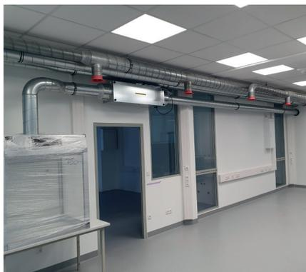
*El digestorio en fase de construcción. Aquí, el aire se extrae a través de un purificador CC 400 y se conduce de forma segura al exterior a través de las tuberías conectadas al sistema de aire acondicionado.*
