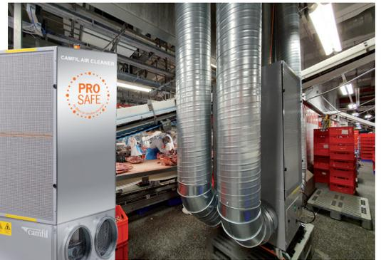
*„Hygiene wird in der Fleischwirtschaft besonders groß geschrieben. Gerade hier ist es wichtig, die Innenraumluft durch entsprechende Hochleistungsfilter zu reinigen, um so Mitarbeiter, Prozesse und Produkte zu schützen. Die Luftreiniger CC 6000 und CC 2000, ausgestattet mit ProSafe HEPA-Filtern H14, sorgen für reine Luft und das bei geringem Energieverbrauch.“*
