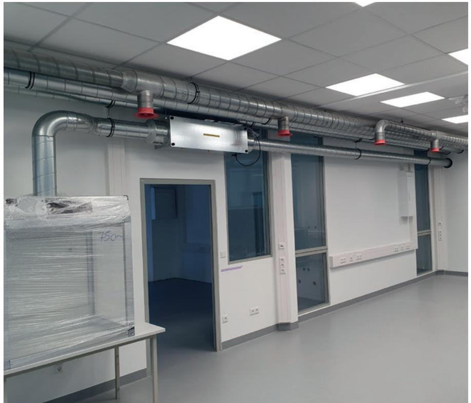
Das Digestorium in der Bauphase. Hier wird die Luft über einen Luftreiniger CC 400 Concealed abgesaugt und über die angeschlossenen Rohrleitung der Lüftungsanlage sicher nach außen geführt.
