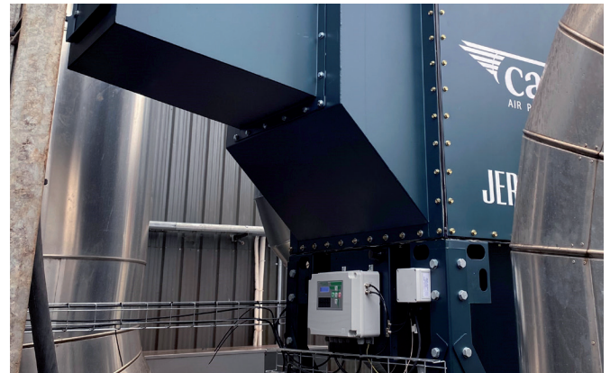
El panel de control ACDC (Camfil APC Advanced Control) está diseñado para actuar como centro inteligente del sistema de captación de polvo.
